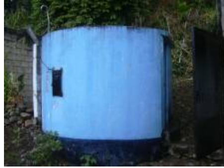
Foto N° 30 : Pozo artesiano Nueva Vista
