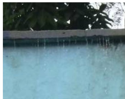
Foto N° 28 : Pérdidas de agua en reservorio
