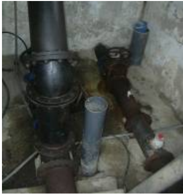
Foto N° 25 : Caseta de válvulas
