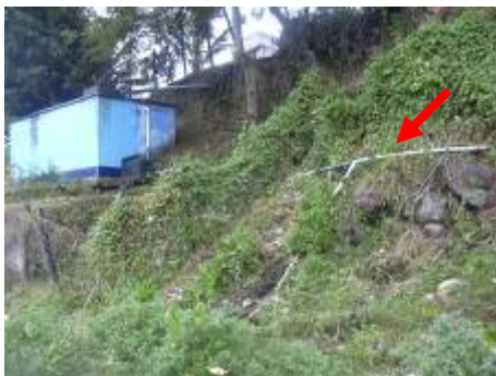
Foto N° 27 : Reservorio y tubería expuesta
