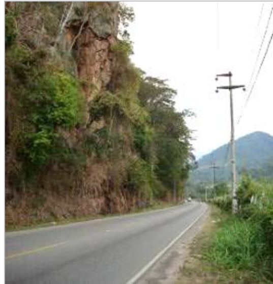
Foto N° 37 : Carretera Central tramo La Merced – San Ramón
