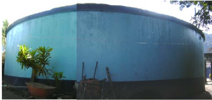
Foto N° 24 : Vista reservorio 600 m3
