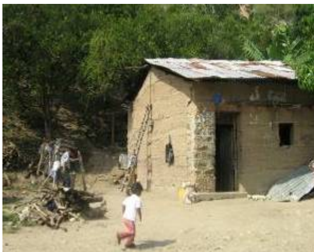
Foto N° 6: Vivienda típica en centros poblados rurales
