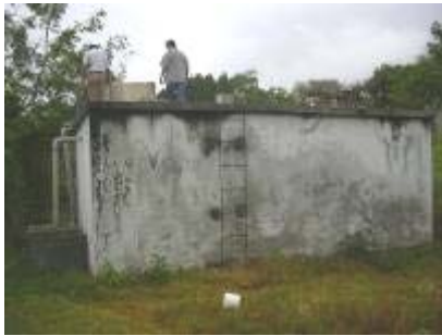
Foto N° 31 : Reservorio Nueva Vista
