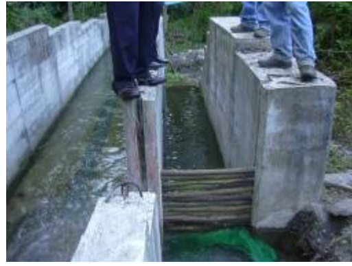
Foto N° 19 : Desarenador incompleto.
