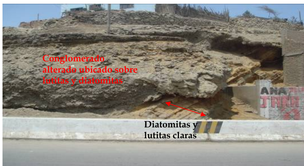
Foto N° 5.14: Las viviendas del Asentamiento Humano están ubicadas sobre materiales superficiales como el conglomerado alterado, nótese que bajo este se ubican diatomitas y lutitas
