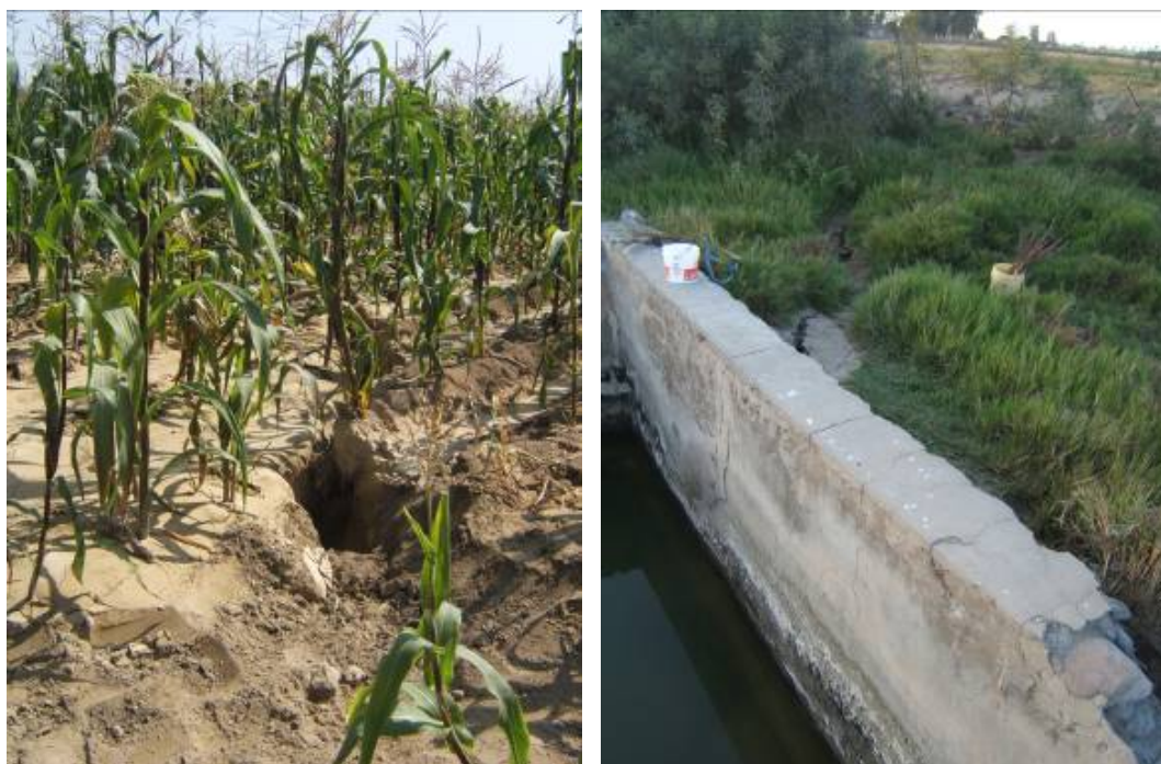
Foto 4.26: Agrietamientos en las chacras y en los canales en el sector de Cabeza de Toro, afectado por licuación de suelos.
