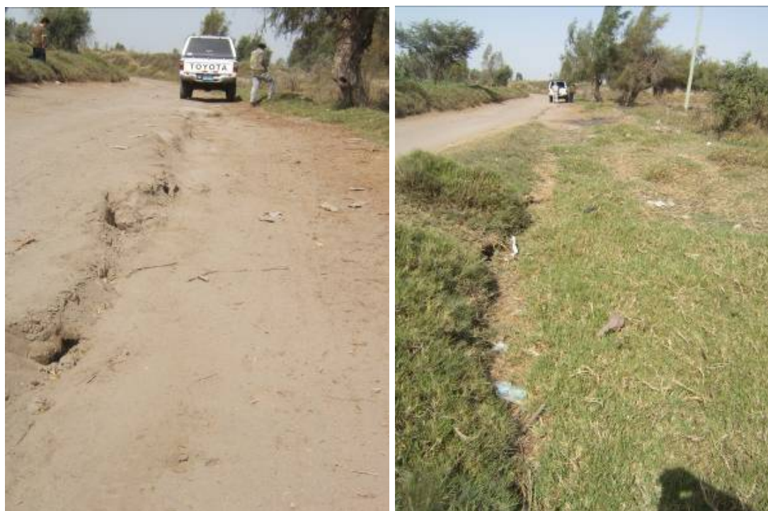
Foto 4.23: Agrietamientos en las trochas como indicios de licuación de suelos en el sector de Cuchilla Vieja.
