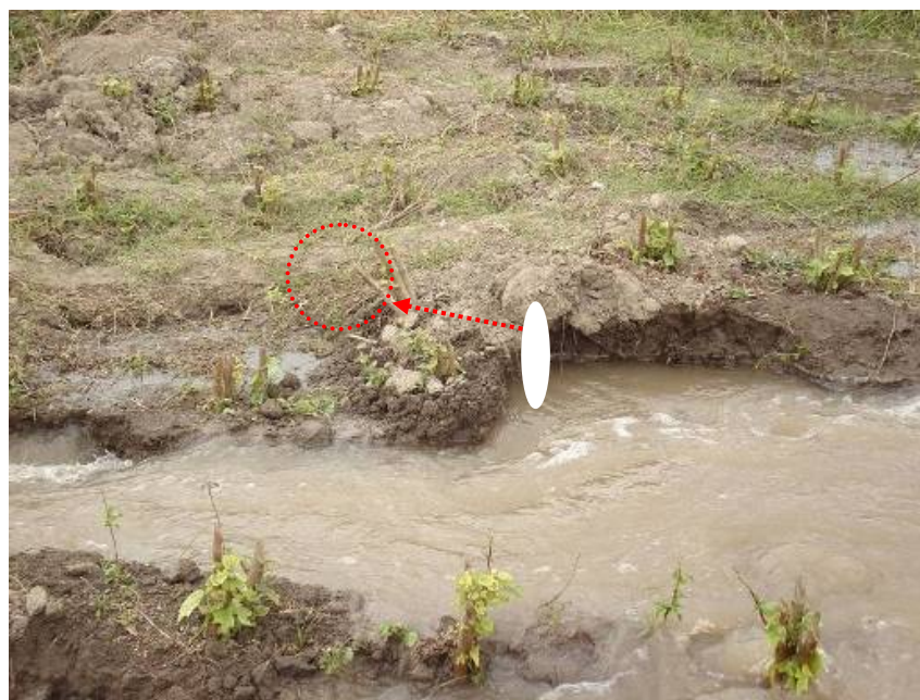
Foto 4.16: Marcado con la elipse blanca se ve la posición original de la planta, y en líneas punteadas su desplazamiento producto de la deformación.
