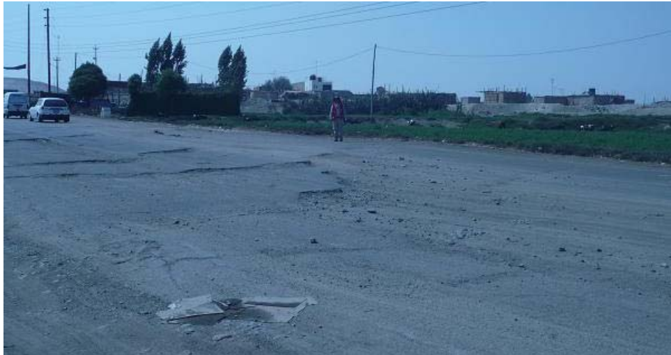
Foto 5.10. Vista de fracturamiento de dirección N 170° observado en la carretera hacia Pisco
