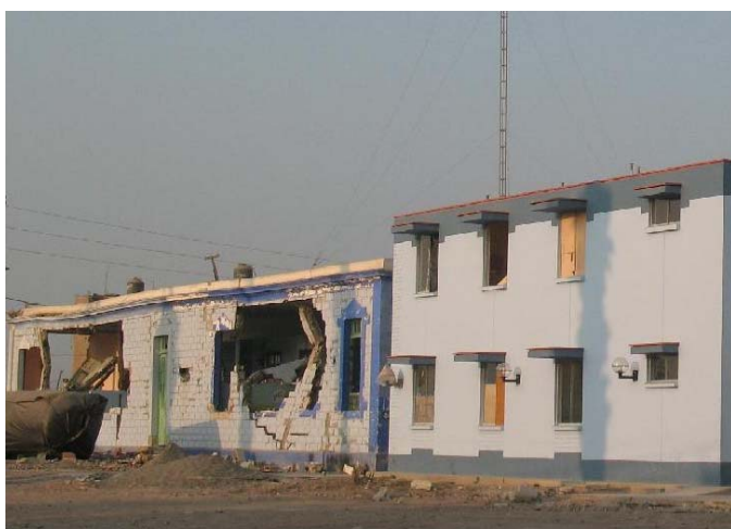
Vista del edificio restante Hospital San Juan de Dios de Pisco
