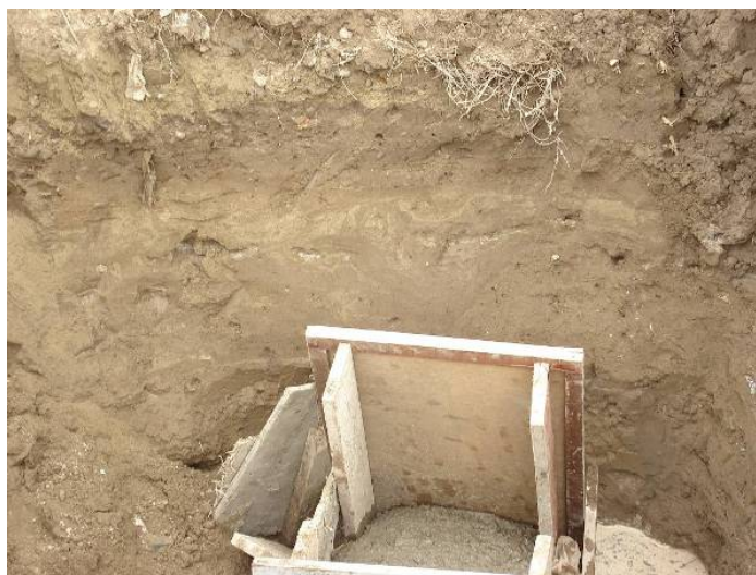
Foto 4.4: Estructuras asociadas a la licuefacción formadas por el sismo.
