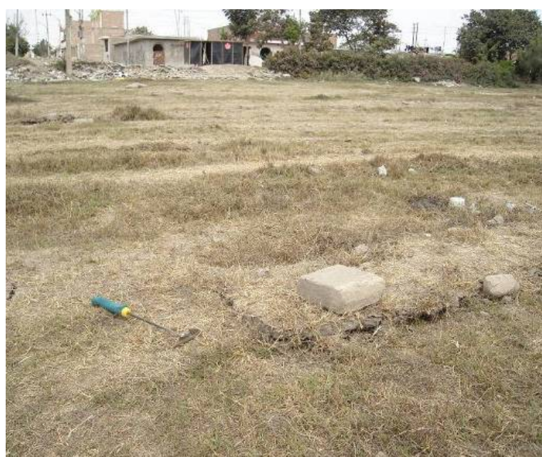
Fotos 4.7 (arrb) y 4.8 (abj): Otros efectos de deformación superficial en el terreno.
