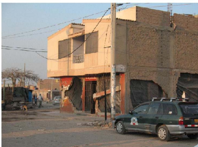
Vivienda al pie del ovalo de la calle Pedro Penagos
