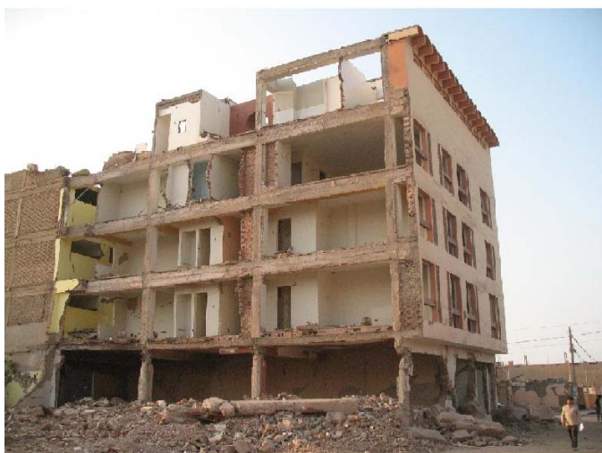
Edificio en la calle Dos de Mayo
