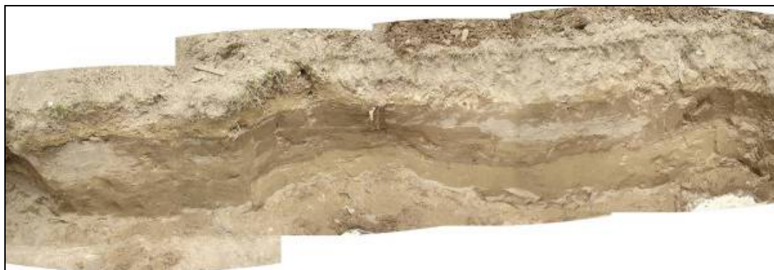
Foto 4.1: Pared sur de la excavación de la tubería, se aprecia claras estructuras producto de la licuefacción.
