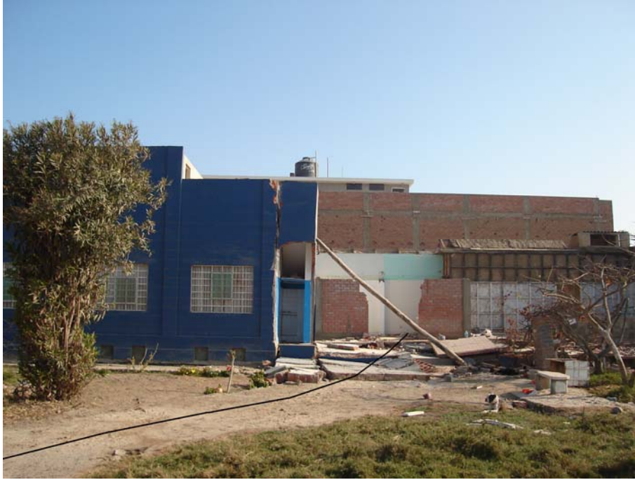
Línea de licuación en Pisco Playa, se aprecia la destrucción producida al paso de la misma. Corresponde a la misma zona de la vista anterior.
