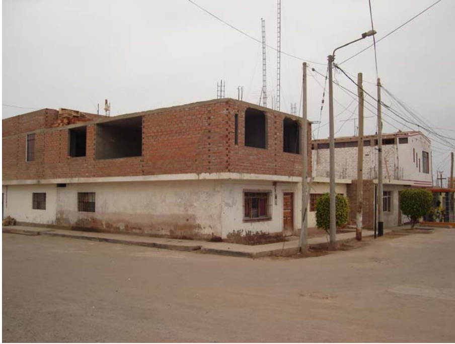
Huella del agua dejada por el tsunami en San Andrés. Corresponde a la zona de la vista anterior.
