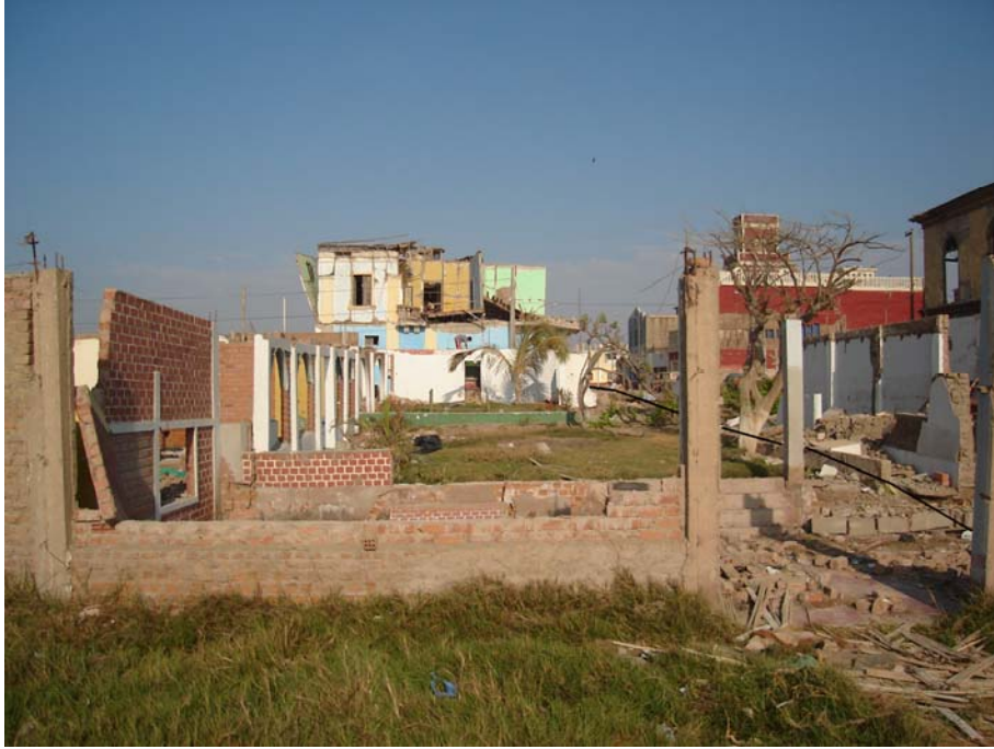
Línea de licuación, nótese la destrucción causada a lo largo de ella. Zona de Pisco Playa.
