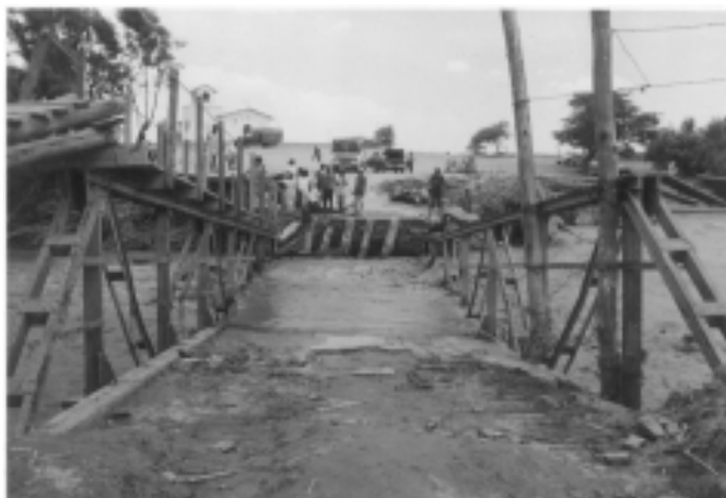
Puente Ocucaje, al sur de la ciudad de Ica, afectado por El Niño. FOTO: Almanaque Estadístico de Ica. INEI.
