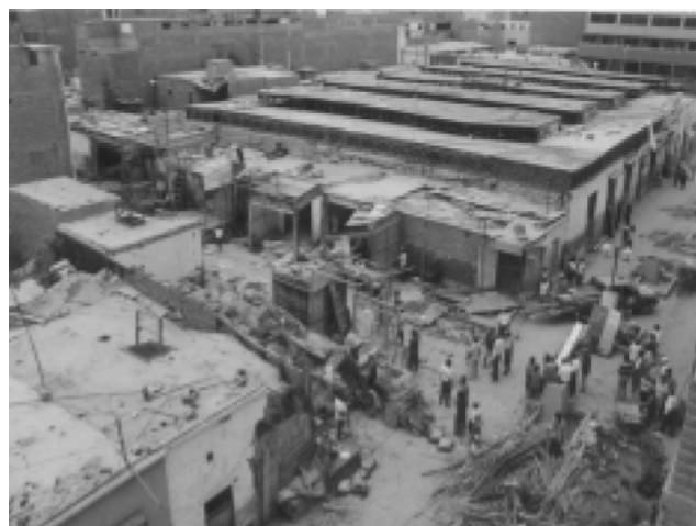
Viviendas afectadas por sismos en la ciudad de Ica Foto: Almanaque Estadístico de Ica. INEI
