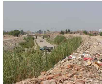
Vista hacia el puente Socorro. Al fondo, depósito fluvial. En primer plano, depósito antropogénico.
