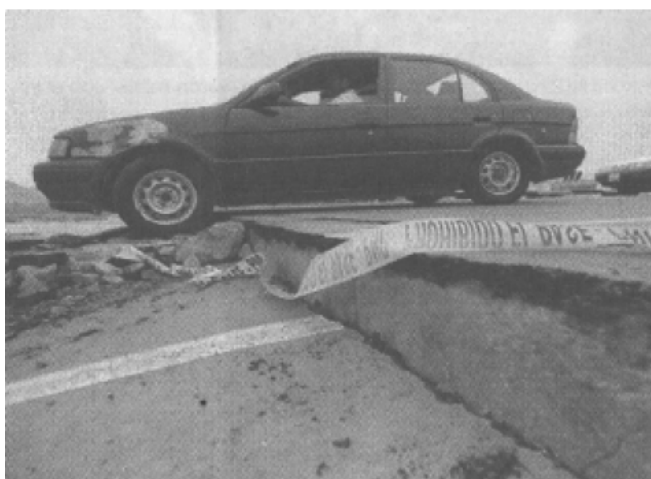
Terremoto del 23 de Junio del 2001. Daños en la carretera Panamericana Sur Foto: Almanaque Estadístico de Ica. INEI
