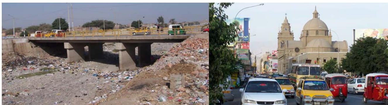
Puente Socorro, vía hacia La Tinguiña y Los Molinos
