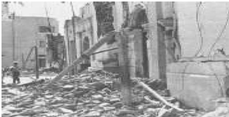
Terremoto de 1950, que destruyó parcialmente la ciudad de Ica Foto: Almanaque Estadístico de Ica. INEI
