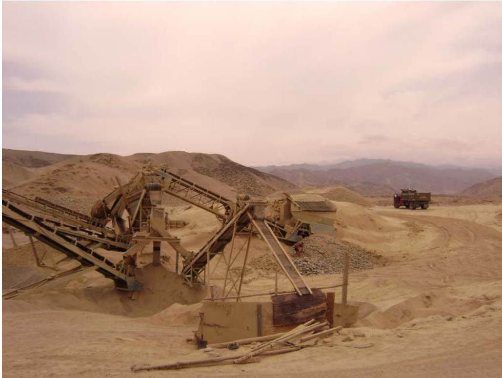
FOTO N° 12: Las dos fotos corresponden a la cantera ubicada al pie de la quebrada Huatianá, se puede apreciar la gran cantidad de material gravoso, que dejó como cobertura algún, evento extremo, que va perdiendo su potencia a medida que se avanza a la ciudad de Chincha Alta.
