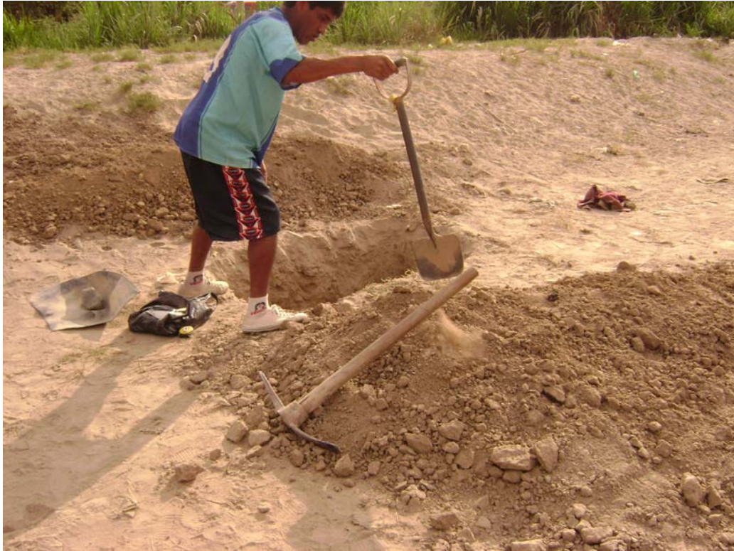
FOTO N° 10: Las dos fotos corresponden a la Calicata N°23, ubicado en Cruz Blanca, futuro mercado de Chincha Alta, el material corresponde a un suelo arcillo arenoso.
