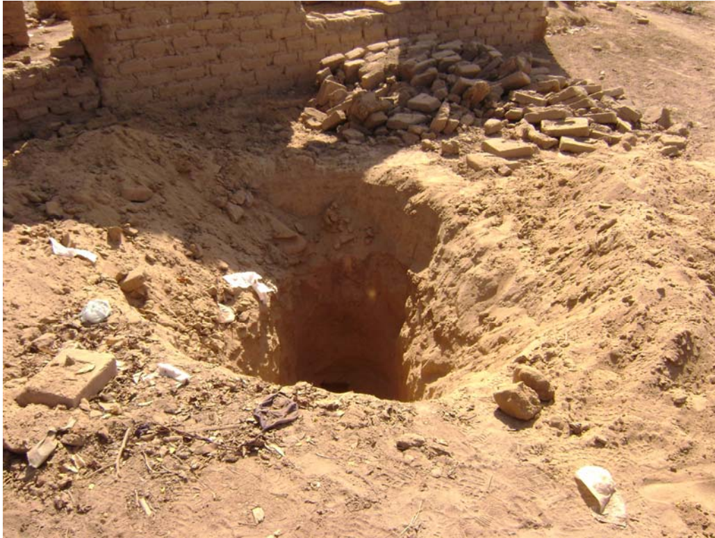
FOTO N° 03: Calicata N°09, ubicado en Grocio Prado, el material corresponde a un suelo areno limoso, que no contiene piedras.
