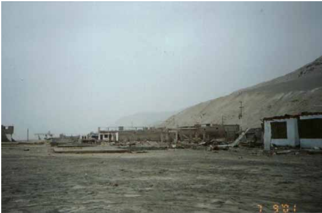
Foto N° 08: Efectos del tsunami en viviendas, Cerrillos - Camaná
