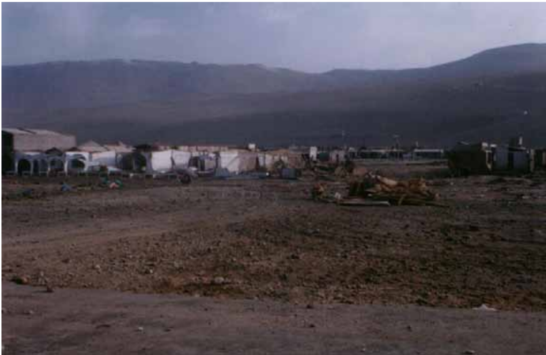
Foto N° 14: Efectos del tsunami, Cerrillos - Camaná
