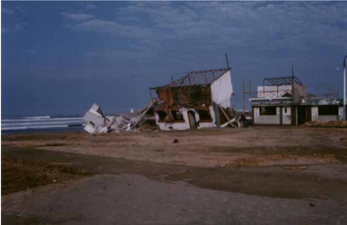
Foto N° 19: Daños en vivienda por efectos del tsunami, La Punta - Camaná
