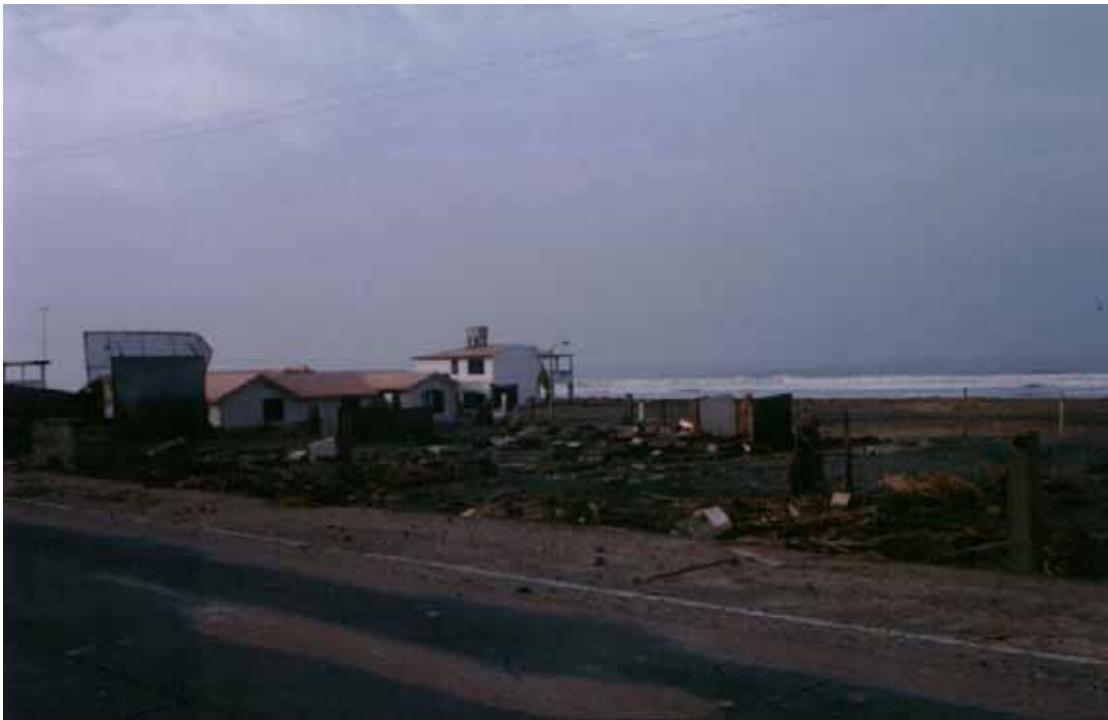
Foto N° 16: Efectos del tsunami, Cerrillos - Camaná
