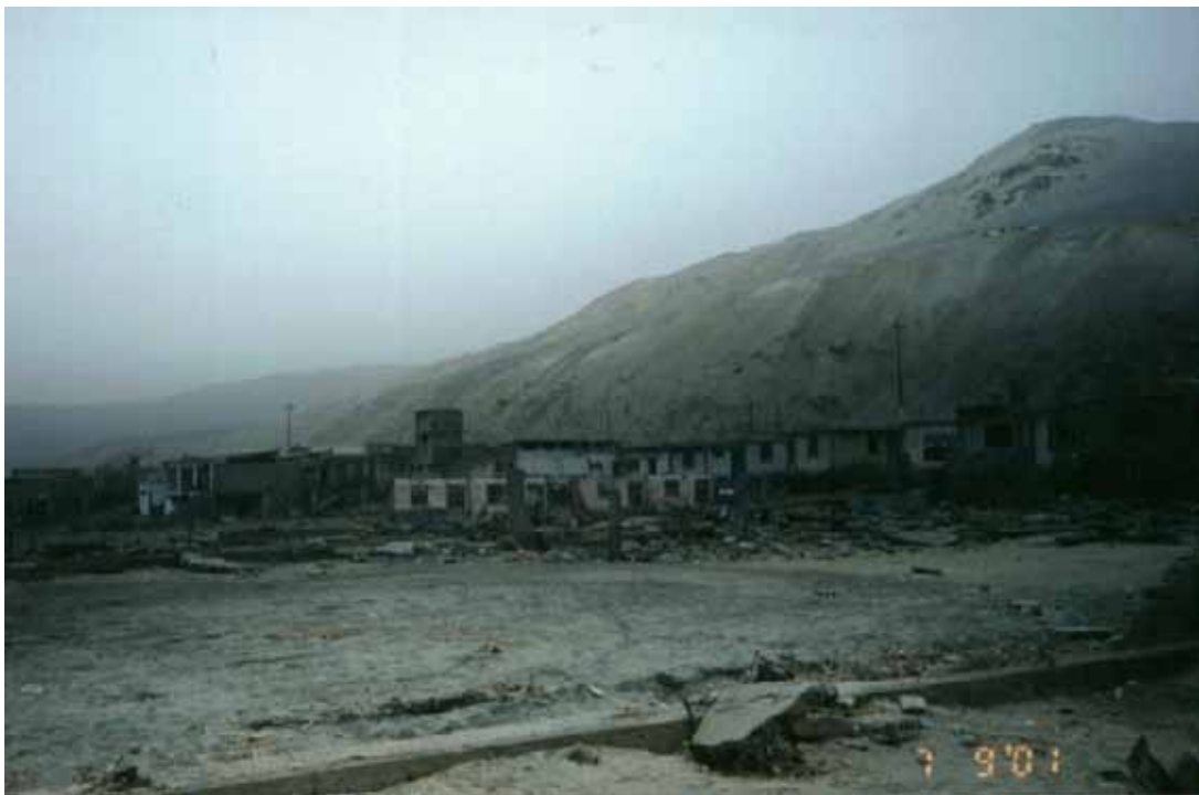
Foto N° 10: Efectos del tsunami en viviendas, Cerrillos - Camaná
