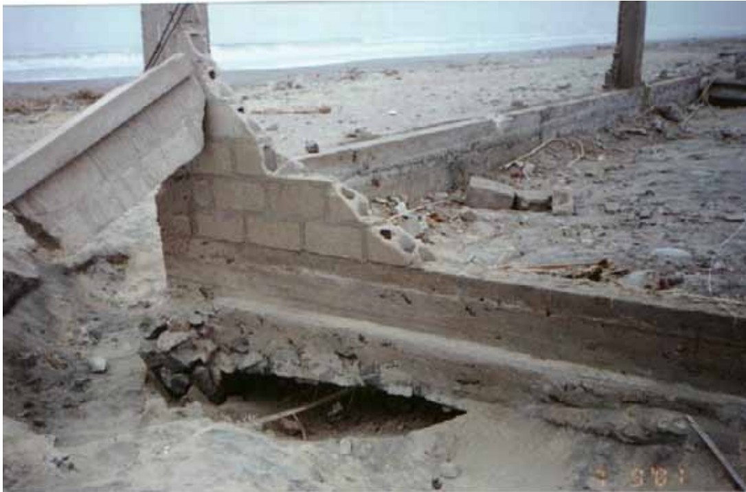
Foto N° 09: Efectos de socavamiento en cimentación, Cerrillos - Camaná
