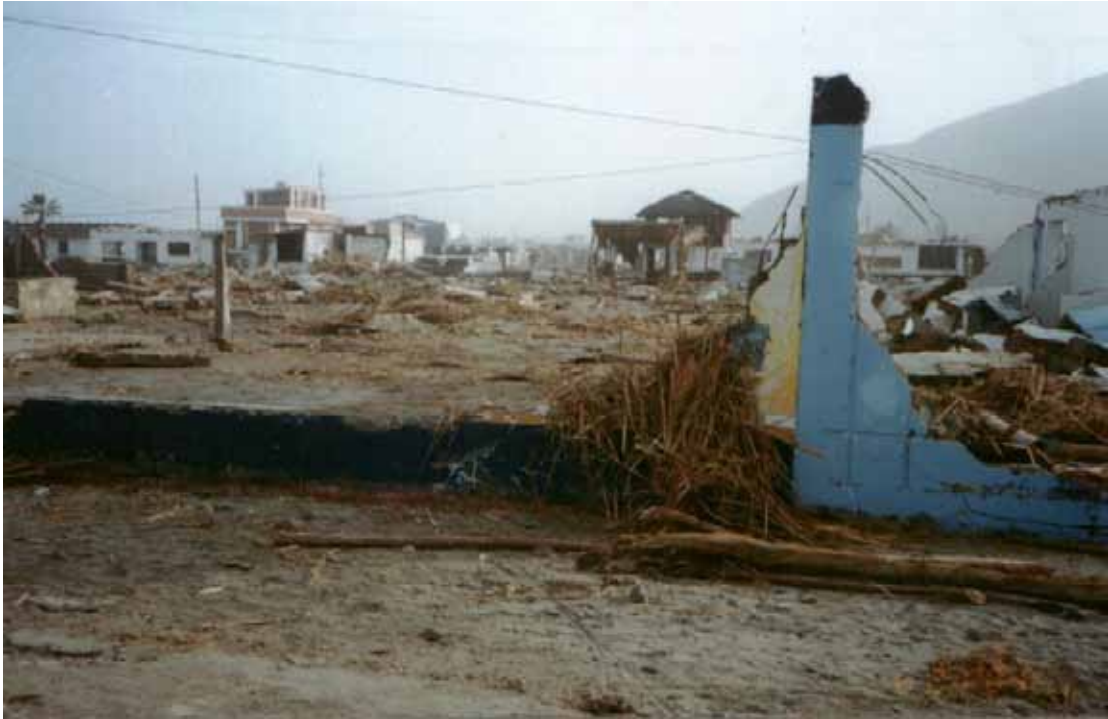
Foto N° 27: Destrucción de muros y viviendas por el tsunami en viviendas, La Punta – Camaná
