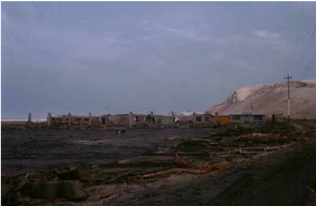
Foto N° 12: Daños en viviendas por efecto del tsunami, Cerrillos - Camaná
