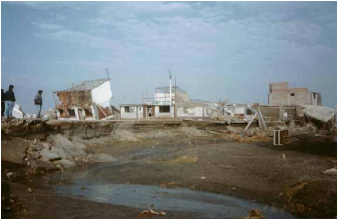
Foto N° 24: Efectos del tsunami en viviendas, La Punta – Camaná
