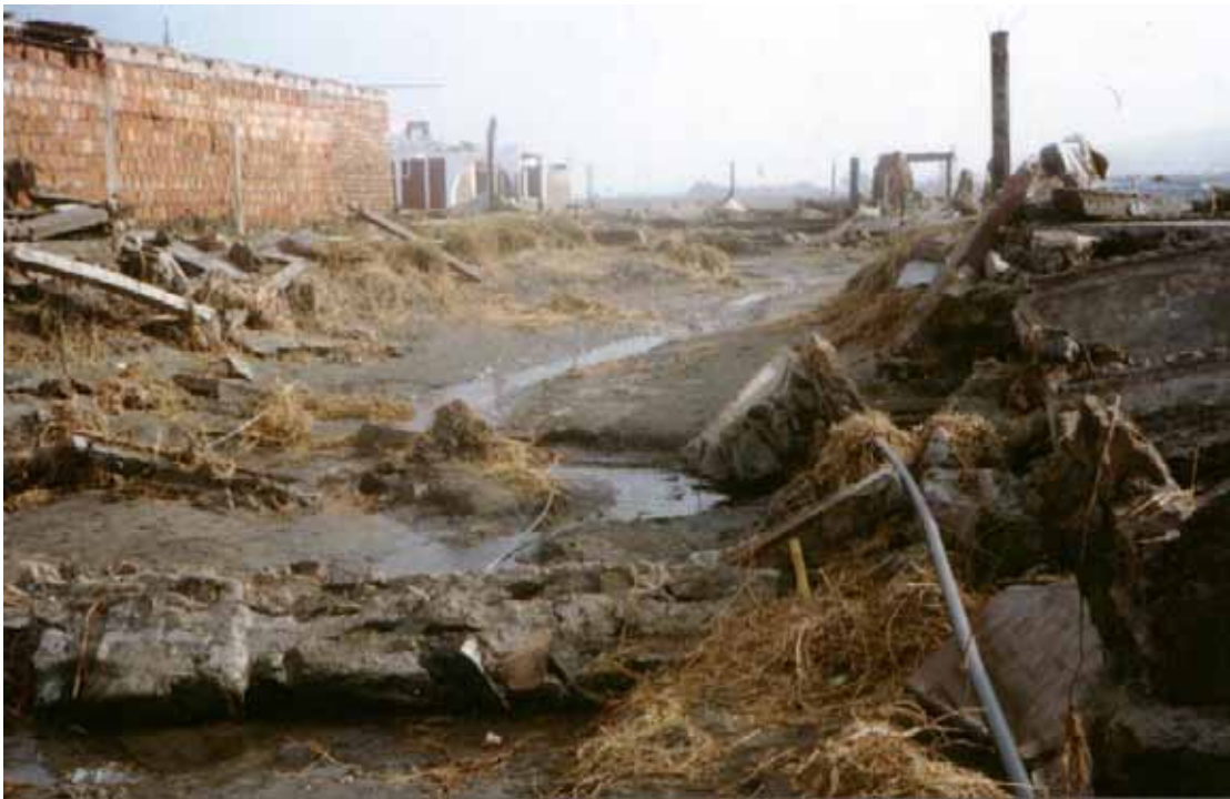
Foto N° 20: Socavamiento del terreno, La punta - Camaná
