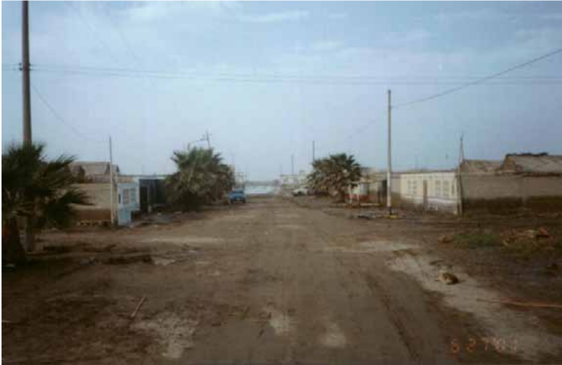
Foto N° 25: Daños en vías por efectos del tsunami, La Punta - Camaná
