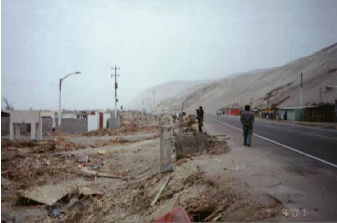
Foto N° 11: Efectos del tsunami, donde se observa hasta donde llegó el agua de mar, Cerrillos - Camaná
