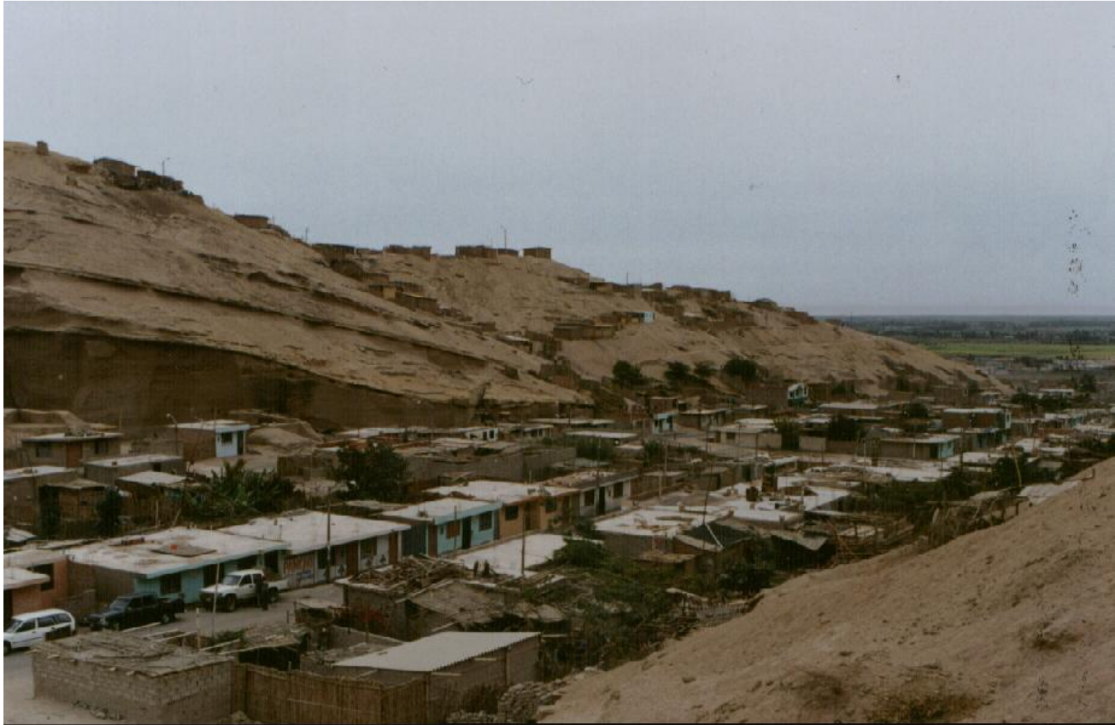
Foto N° 4: Daños moderados en la Urb. Juan Pablo Vizcardo y Guzmán, Problemas de asentamientos en zonas de relleno y peligro por activación de quebradas.
