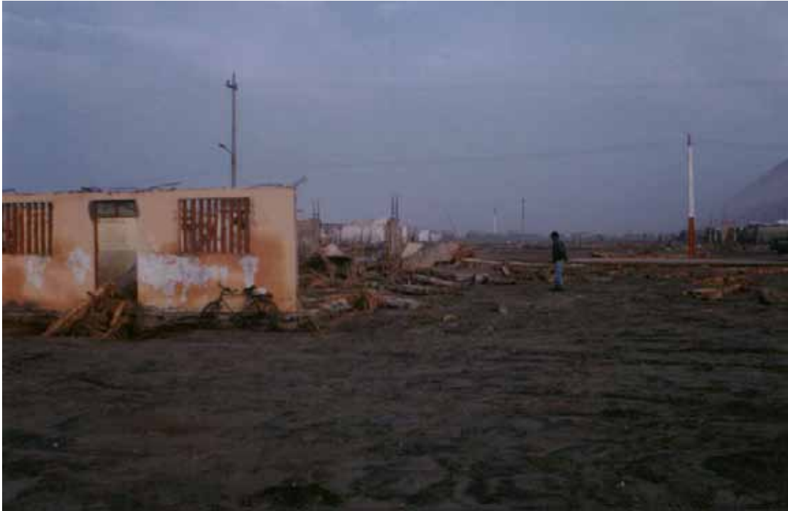
Foto N° 15: Daños en viviendas por efectos del tsunami, Cerrillos - Camaná
