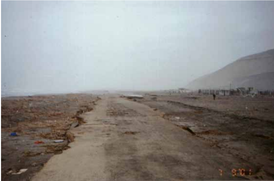
Foto N° 05: Pista en Cerrillos afectados por el Tsunami - Camaná
