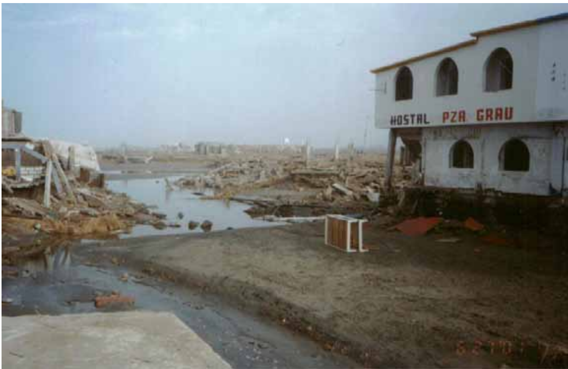
Foto N° 26: Pequeñas lagunas remanentes por efectos del tsunami, La Punta - Camaná
