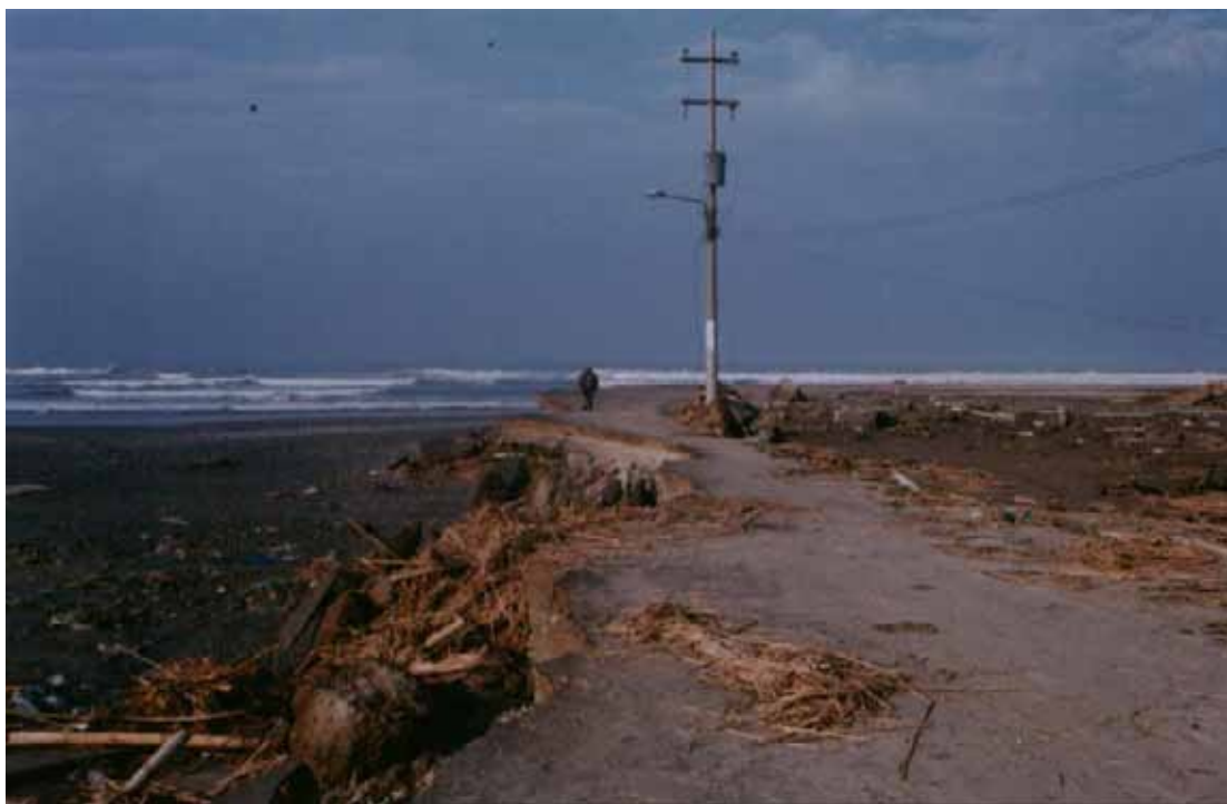
Foto N° 18: Efectos de socavamiento en vía afirmada, Cerrillos - Camaná
