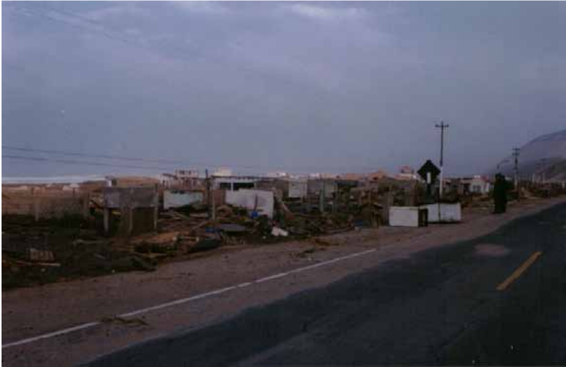
Foto N° 13: Efectos del tsunami, Cerrillos - Camaná
