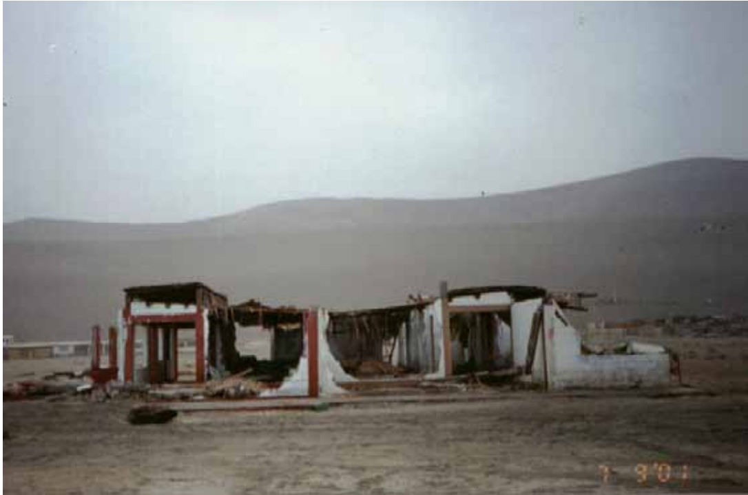
Foto N° 07: Efectos del tsunami en viviendas, La Punta Camaná
