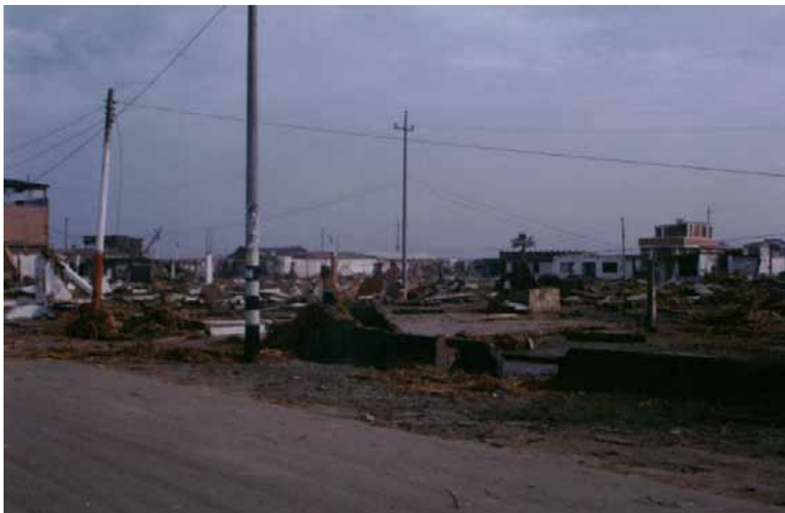
Foto N° 17: Daños por efectos del tsunami en viviendas, La Punta - Camaná
