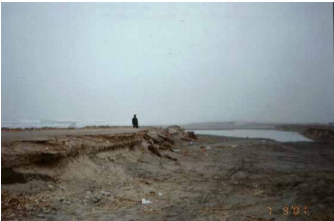
Foto N° 06: Vista hacia la punta, se observa los efectos de socavamiento por acción del agua en el momento de su retorno al mar
