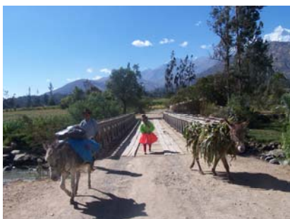
Puente sobre el río Santa – Yungay.
