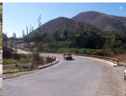
Puente sobre el río Ancash – Yungay
