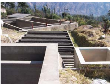
Planta de Tratamiento de agua potable – Yungay
