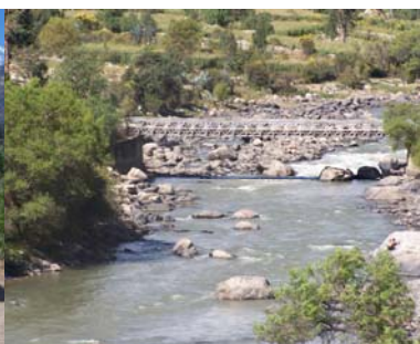
Puente sobre el río Santa – Yungay
